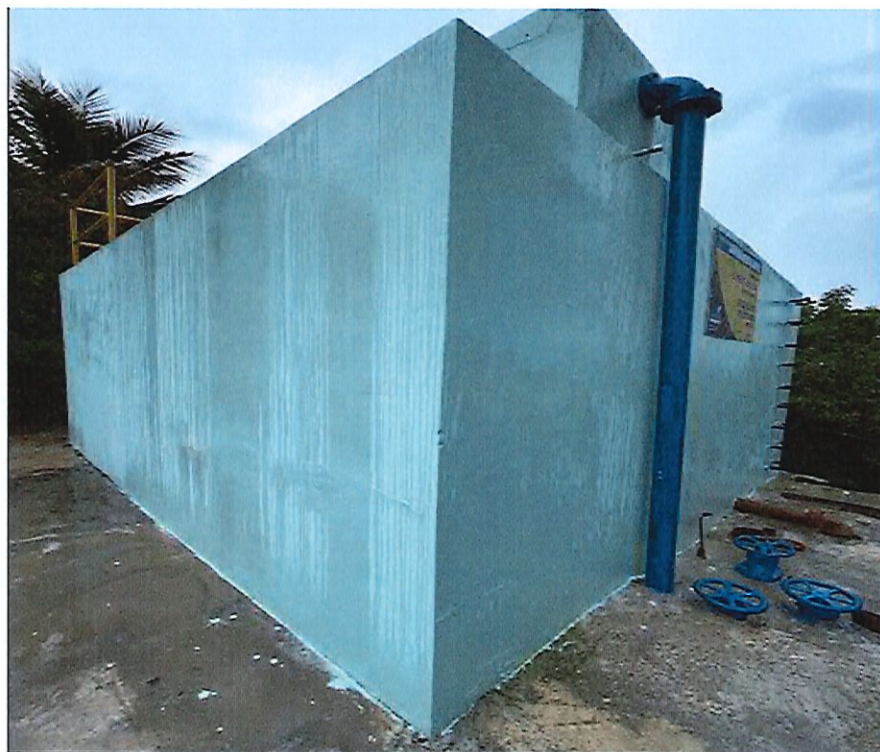
Rehabilitación Tanque confesor Heredia Figura (1)
